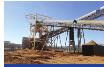
Строительство узла пересыпа обогатительной фабрики
