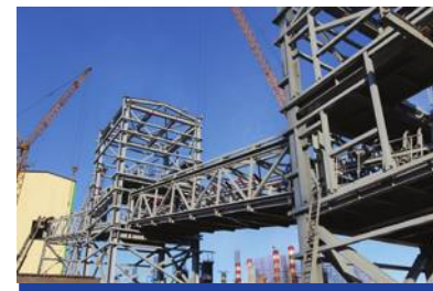
Изготовление, монтаж и шеф-монтаж, промышленная автоматизация конвейерного оборудования для МПТ «Усть-Луга» для «Европейский серный терминал»
