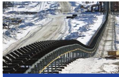
Монтаж магистральных конвейеров
