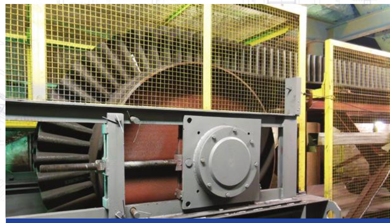
Крутонаклонный КЛС с применением ленты с гофробортом
