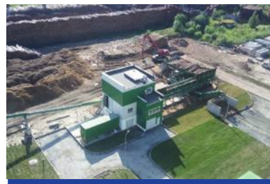
Монтаж и пусконаладка оборудования линии топливоподдачи ТЭЦ, строительство промежуточного склада щепы, здания рубильной машины
