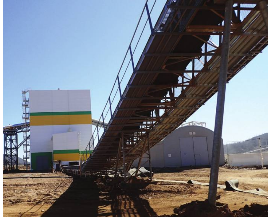
Строительство промышленных объектов и монтаж магистральных конвейеров для Nordgold. Якутия, 2018-2019 год
