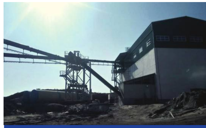
Строительство склада хранения щепы и системы топливоподачи
