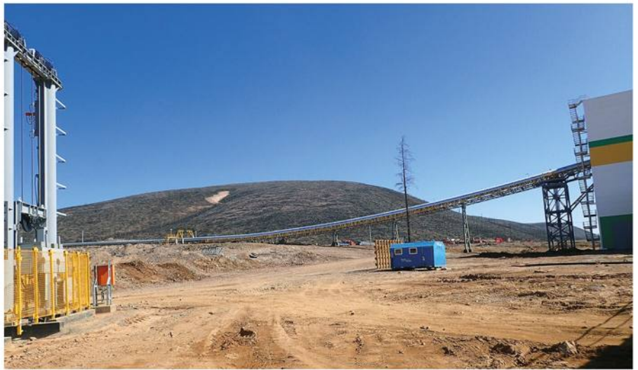
Строительство золотоизвлекающей фабрики. Компания Nordgold, месторождение «ГРОСС»
