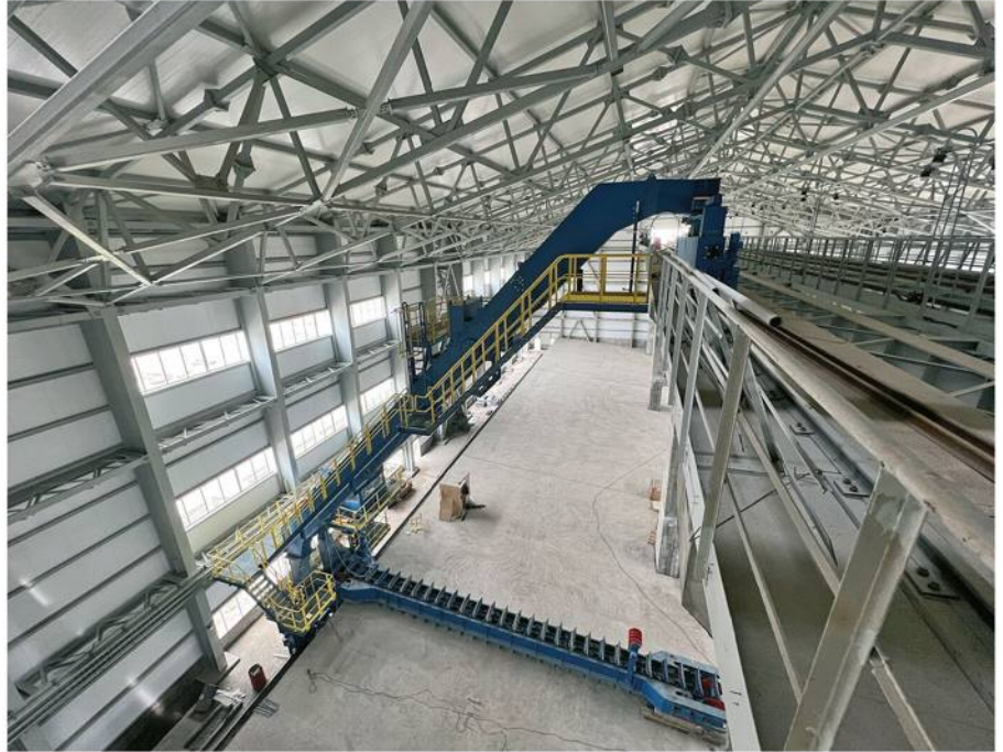
Монтаж кратцер-крана производства НПО «Аконит», Казахстан, 2022 год
