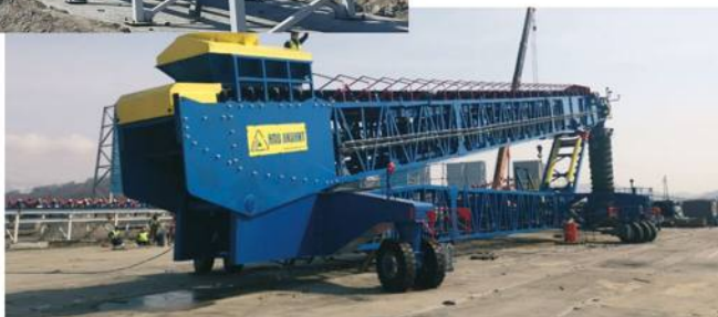
Монтаж судопогрузочной машины в порту на Дальнем Востоке, март 2022
